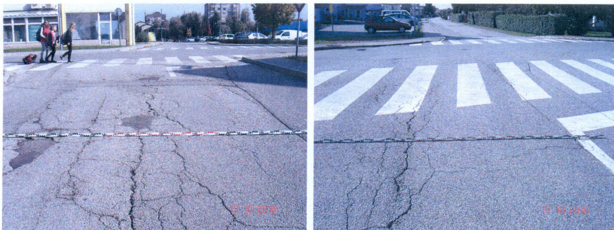
Slika 3: Poškodbe vozišča Hrastinška pot (levo) priključek Lidl Idesno), okt. 2016
