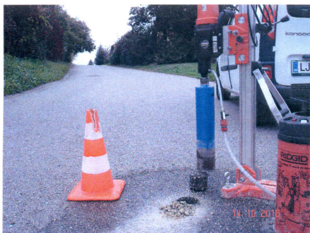
Slika 9: Sondiranje tal, okt. 2016
