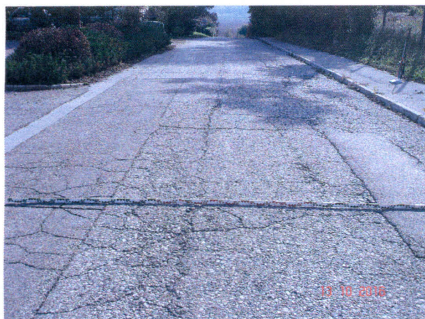
Slika 4: Poškodbe vozišča, okt. 2016
