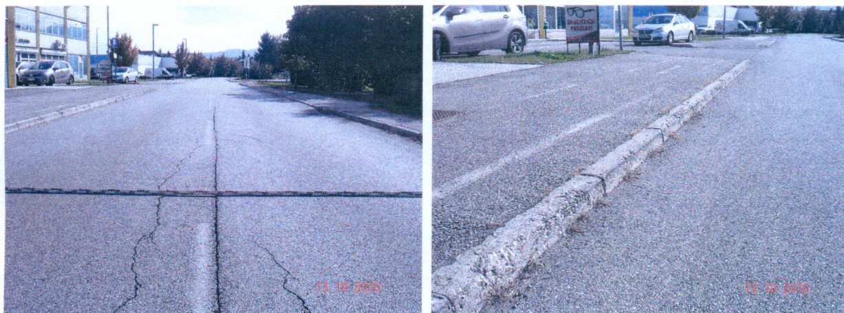
Slika 2: Poškodbe vozišča, okt. 2016
